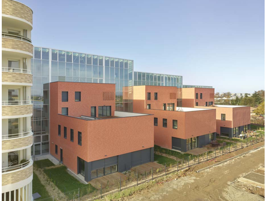
▲ Au nord, les voiles béton des trois plots d'habitat intermédiaire, desservis par la rue vitrée centrale, sont parés de briques rouges.
