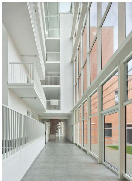
▲ La venelle bioclimatique vitrée (6 × 67 m), qui accueille les coursives de desserte des logements, est régulée thermiquement par des ventelles ouvrables, hautes et basses.
