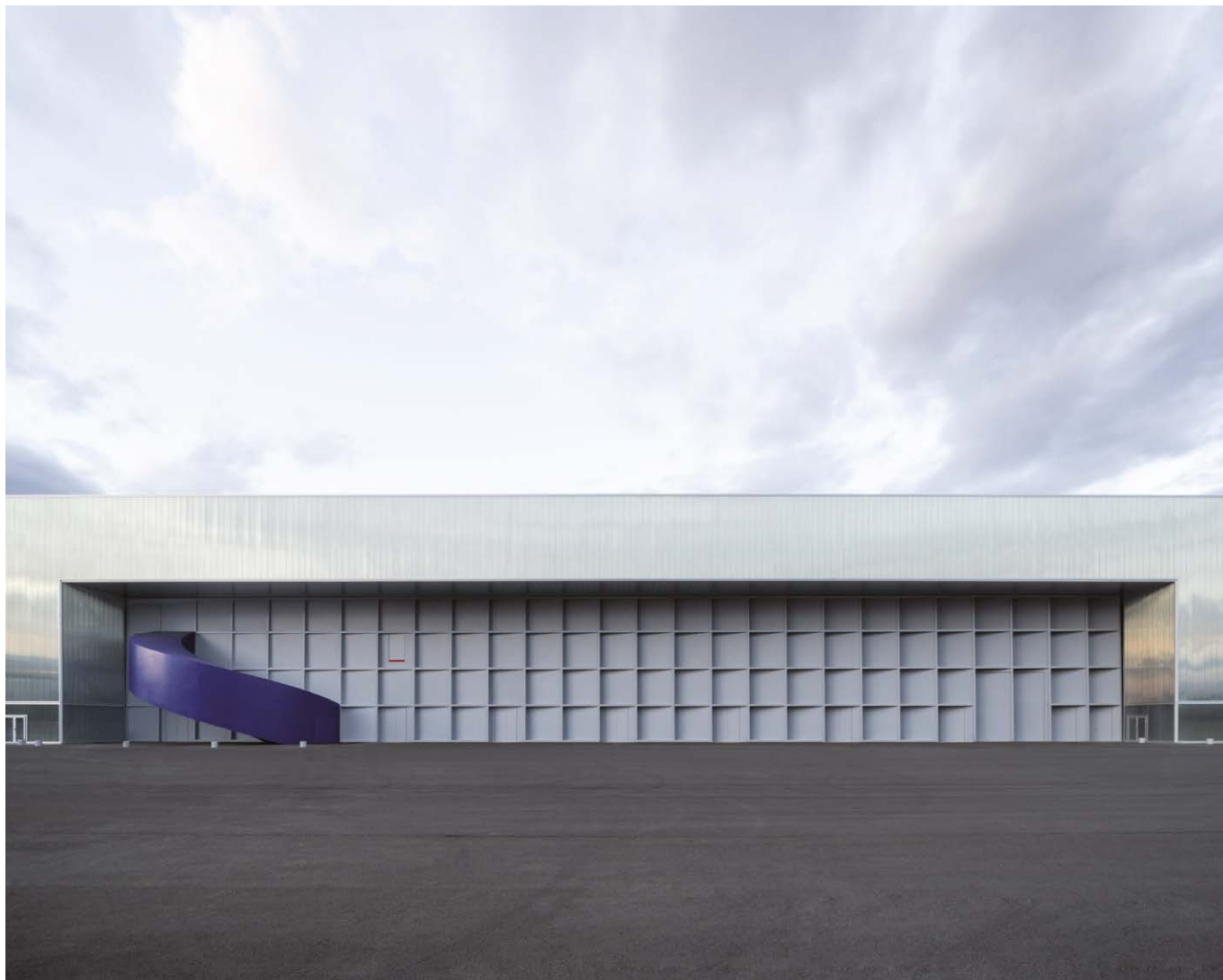
L'escalier en spirale formé d'un caisson en tôles d'acier.
