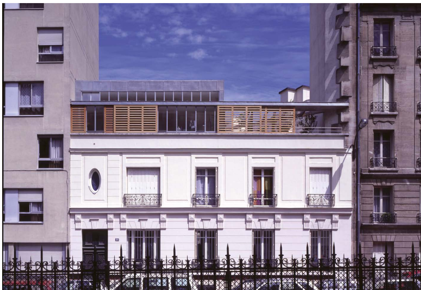
Maison de ville, Paris 18 e arr. ; Soon Architectes. Accolée à deux grands immeubles, cette maison de ville mitoyenne de deux niveaux a été surélevée d'un étage en attique au moyen d'une structure en acier et bois.
