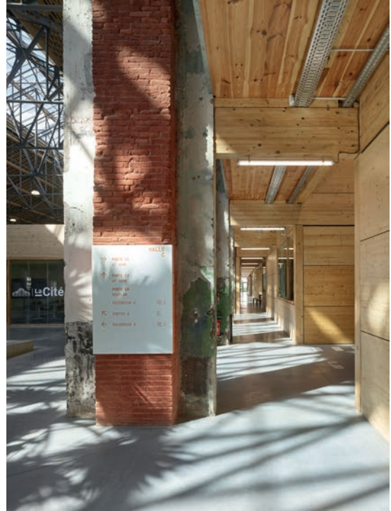
Gereinigter Backsteinpfeiler mit vorgelagerten Betonrahmen © Roland Halbe
