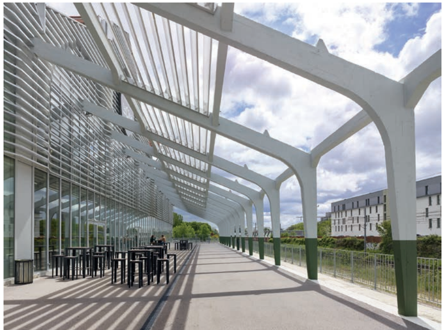
Südöstliche Fassade mit Terrasse (Laderampe) und Vordach aus Betonhalbrahmen © Roland Halbe
