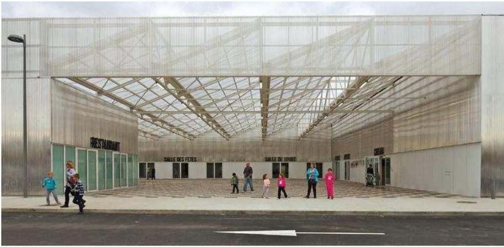
[5] Abhängig von den Tageslichtverhältnissen wirkt die Perforation an Teilen der Wellaluminiumhülle stärker oder schwächer
